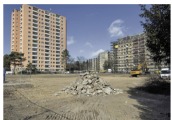
Lidl Bauplatz Falkenseer Chaussee Foto: Arndt Meißner
